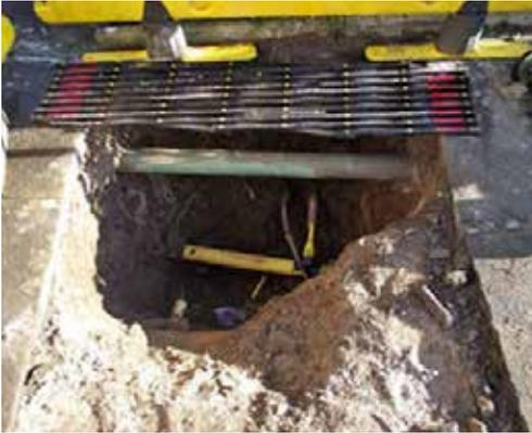
Le treillis Trench-Protect replié est posé à une extrémité de la tranchée ouverte.
