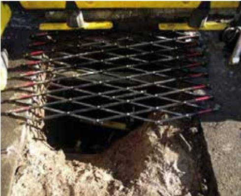
Le treillis forme une protection sur la tranchée ; le treillis peut être déployé pour davantage de stabilité.
